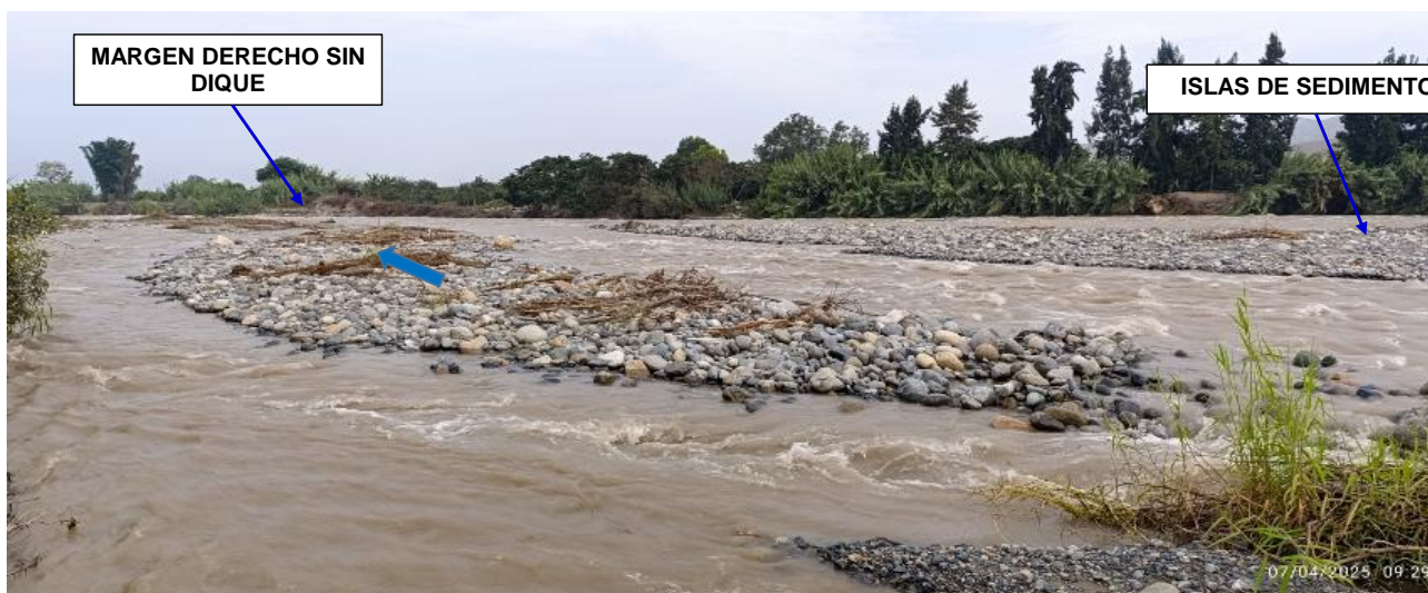
FIGURA N°04: RIO CHANCAY-HUARAL, CON LA MARGEN DERECHA AFECTADO POR EROSION DEJANDO EL TRAMO SIN DIQUE CON MUROS DE CONTENSION COLAPSADO PONIENDO EN RIESGO A DESBORDE LAS ÁREAS DE CULTIVOS DEL SECTOR HUANDO.
