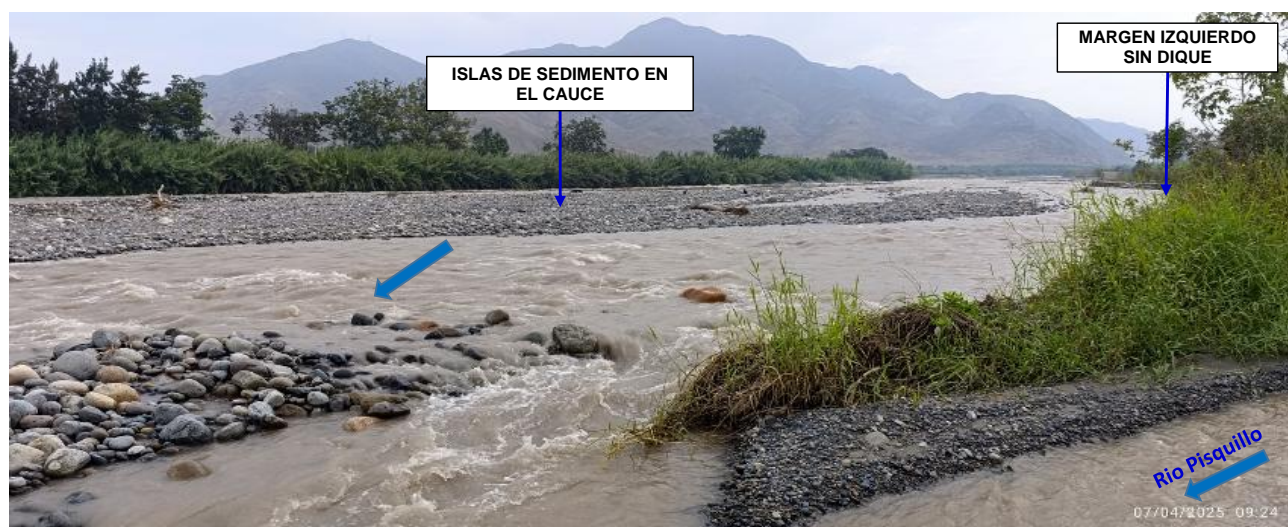
FIGURA N°02: CAUCE DEL RÍO CHANCAY-HUARAL, CON PRESENCIA DE ISLAS DE SEDIMENTOS, DESVIANDO EL CAUDAL HACI EROSION EN LOS DIQUES Y TRAMO DE LA MARGEN IZQUIERDA DEL RÍO SIN DIQUE.
