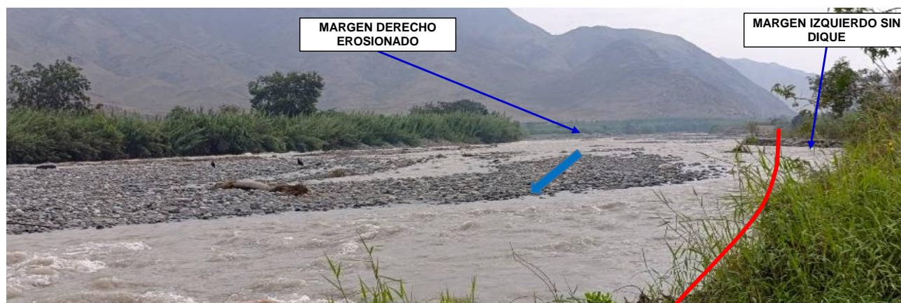
FIGURA N°01: RÍO CHANCAY-HUARAL, TRAMO BARRAJE HUANDO - RÍO PISQUILLO CON DIQUES EROSIONADOS POR EL CAUDAL, TRAMO DE MARGEN IZQUIERDO SIN DIQUE.
